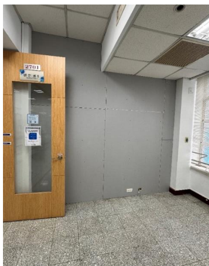
【圖 13 研討室隔音牆施工過程】
