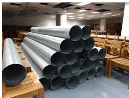
【20170906 架設空調新風管】
