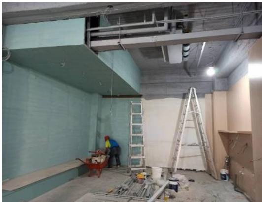
【照片 11：輕食區油漆工程】
