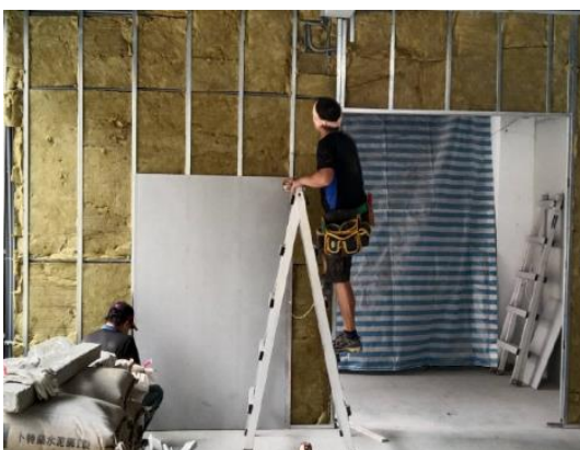
【照片 7：新隔間牆上裝設吸音棉】
