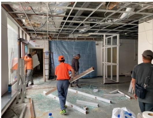
【照片 5：隔間牆及天花板拆除】
