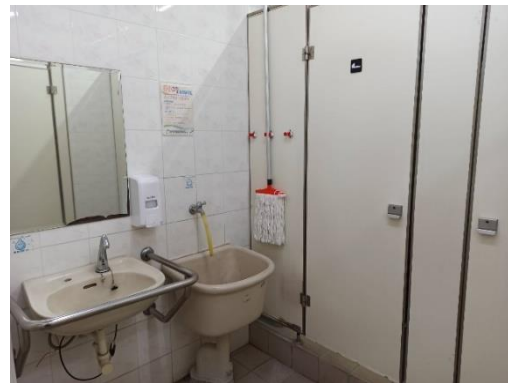
【照片 4：整修前閱覽室廁所】
