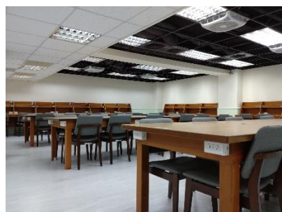
【圖 7 一般區 地板更新 (完工)】
